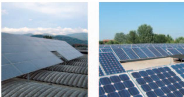
Las plantas parcialmente integradas son las instalaciones en las que los módulos se colocan conforme a las tipologías enumeradas en la tabla 3.1, sobre elementos del mobiliario urbano, sobre superficies exteriores de cerramientos de edificios, o sobre edificios y estructuras con cualquier función y finalidad sin sustituir los materiales de fabricación de tales estructuras (figura 3.2).
