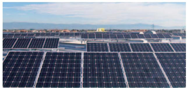
Las células fotovoltaicas de los módulos no son exactamente iguales a causa de desviaciones de fabricación inevitables, por lo tanto es posible que dos bloques de células conectados en paralelo no posean la misma tensión. A consecuencia de esta diferencia, se genera una corriente que fluye desde el bloque de células de mayor tensión hacia el bloque de menor tensión. De este modo, parte de la energía generada por el módulo se pierde dentro del mismo módulo (pérdidas por desequilibrio).
