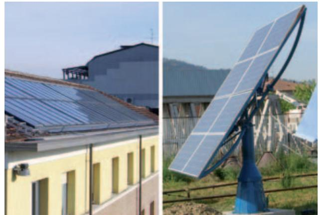
Varios paneles conectados eléctricamente en serie componen una cadena, y varias cadenas conectadas en paralelo para generar la potencia necesaria constituyen el generador o huerto fotovoltaico (figuras 1.11 y 1.12).
